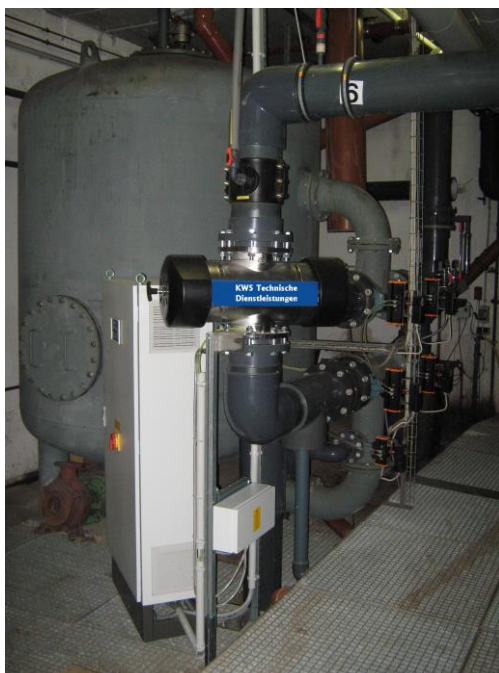
Foto: H 2 O 2 -Filter-UV- Verfahren, Quelle: KWS Technische Dienstleistungen e.K., Dipl.-Ing. Arnim Beyer
